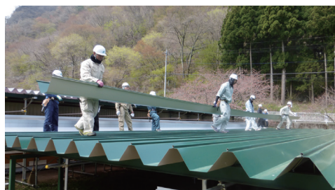
20メートルの屋根伏せ訓練
