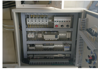
非常用発電装置
